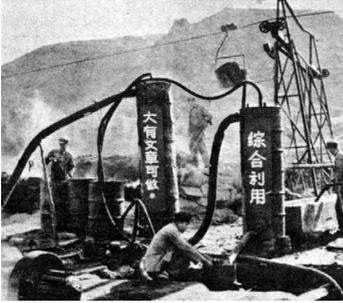
China 1972: Die einfache Anlage wurde aus Schrott gebaut, um Teer, Gas, Dieselöl und Asphalt aus Abfallstoffen zu gewinnen
