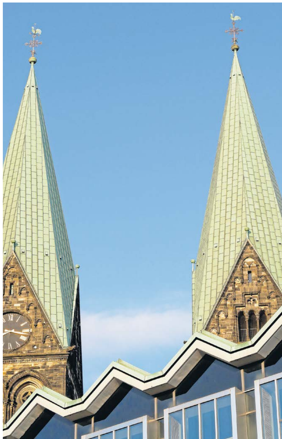
Der St.-Petri-Dom ist die Kirche der größten evangelischen Gemeinde Bremens.
