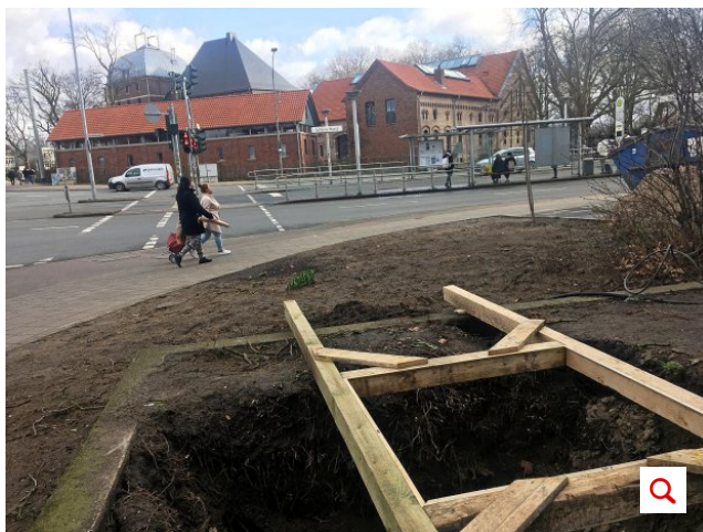
Die Lenin-Statue wird direkt gegenüber von Schloss Horst in Gelsenkirchen aufgestellt. Im Vordergrund: die bereits ausgehobene Baugrube fürs Fundament. Foto: Thomas Richter
